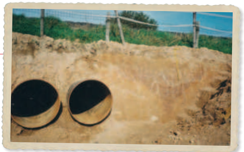
Profil des Grabenwerkes (Spitzgraben), das die Bandkeramikersiedlung umgab; Anschnitt bei der Verlegung der Fernwärmeleitung Weisweiler-Aachen bei Wambach-Weidener Hof (Foto G. Breuer 1995).
